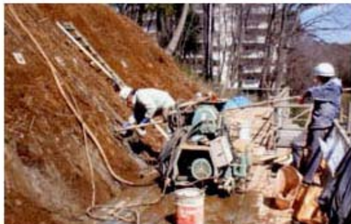
アースネイリング工法の施工状況
