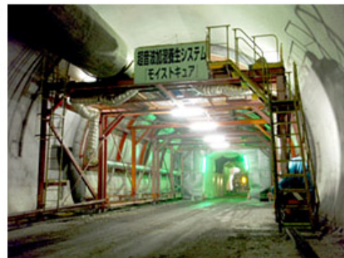
北海道のトンネル工事に導入して成果をあげました
