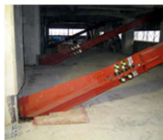
制震改修事例
