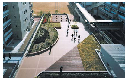
屋上緑化 (神戸市立科学技術高等学校)
