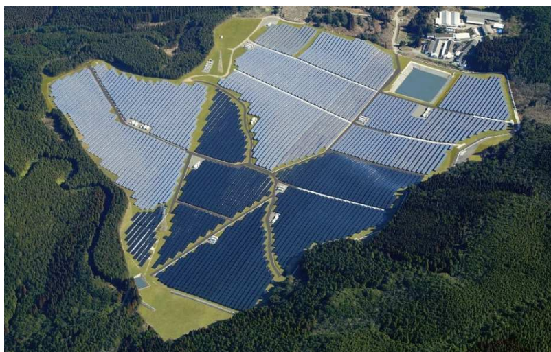
プロジェクト 01 芦北太陽光発電所
