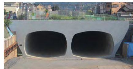
さがみ縦貫川尻トンネル坑口全景
