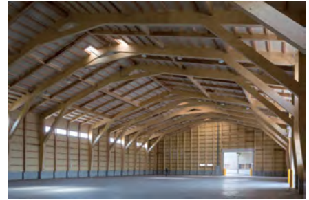
日新木造倉庫(オメガウッド)
