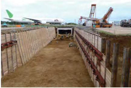
斜め土留め工法 (成田国際空港 第2木の根トンネル設置工事)
