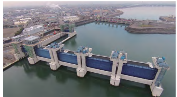
日光川水閘門
