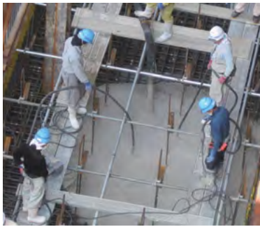
クリーンクリートの打設状況
