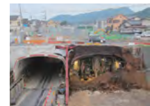
地上発進時(左)と地上に到達したシールド機(右)
