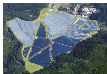
芦北太陽光発電所
