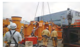
タワークレーンの架台(土台部分)組み立て
