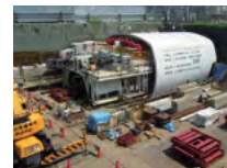
地上発進時(左)と地上に到達したシールド機(右)
