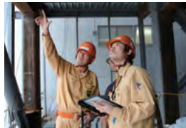
タブレット端末に図面を表示し施工状況を確認
