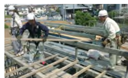
足場の組み立て
