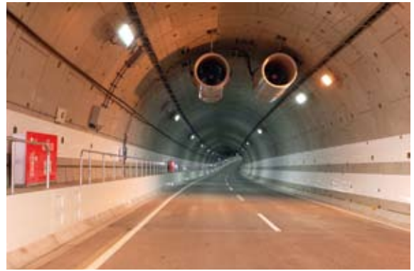
阪神高速 稻荷山トンネル('09) 所在地／京都市
