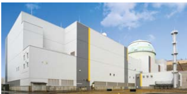
北海道電力 泊発電所3号機タービン建屋他('08) 所在地/北海道古宇郡
