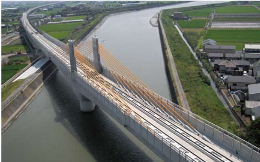
九州新幹線 大野川橋りょう ('09) 所在地 / 熊本県宇城市
