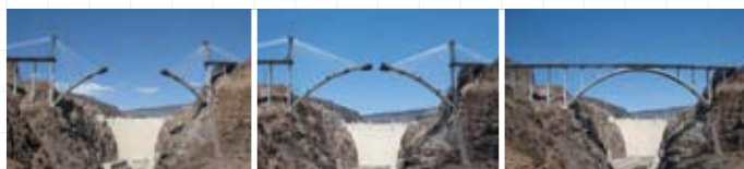
アーチ部の施工(後方に見えるのがフーバーダム)
