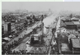
1933 大阪地下鉄(淀屋橋・北久太郎町間)
