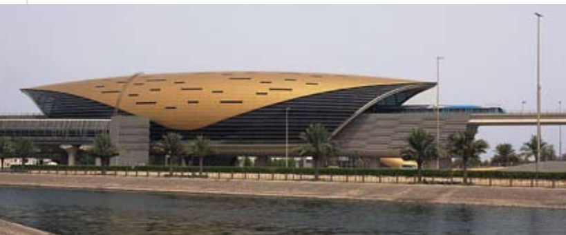
Mall of the Emirates 駅
