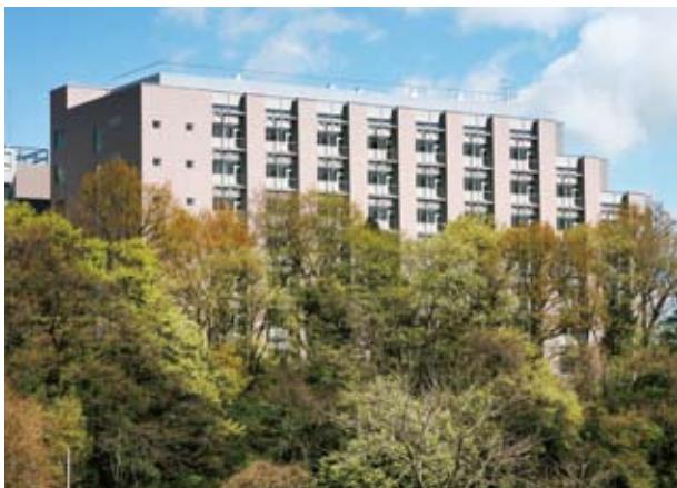
城西大学 18号館('09) 所在地/埼玉県坂戸市
