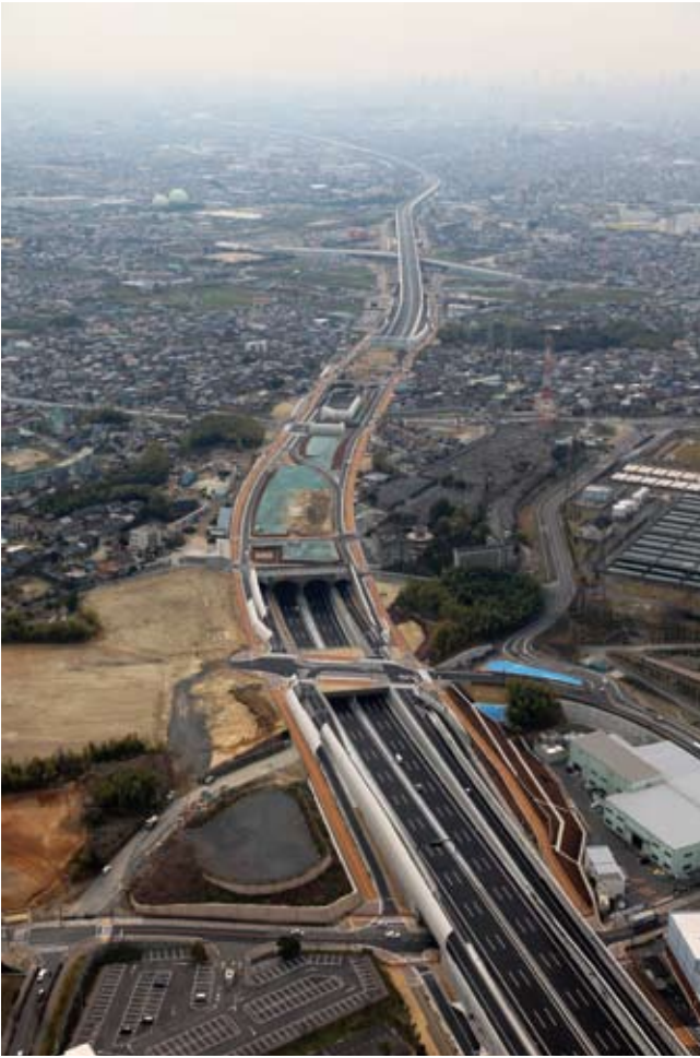
第二京阪道路 打上('10) 所在地／大阪府寝屋川市
