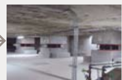
建物基礎部分(免震化後)
