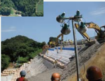
大型発泡スチロールで盛土上部の荷重を軽減
