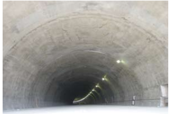
新東名高速道路 掛川第三トンネル('09) 所在地／静岡県掛川市
