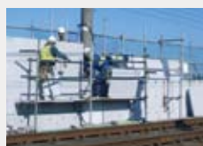
セメントボードの設置作業
