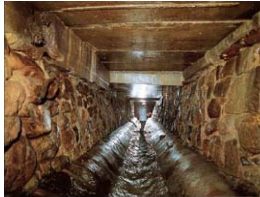
太閤下水：豊臣秀吉が最初に造った太閤下水は開架式だったが、その後閉架式となり、現在でもかなりの部分が使用されている。「千年都市大阪 まちづくり物語」財団法人大阪市都市工学情報センター発行より 提供：大阪市建設局
