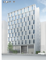
所在地：東京都千代田区 規模：地上9階 地下1階 延床面積：8,168.04㎡ 事業主：大林新築不動産
