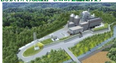
国産材を使った木質バイオマス発電所としては国内最大級の発電規模
