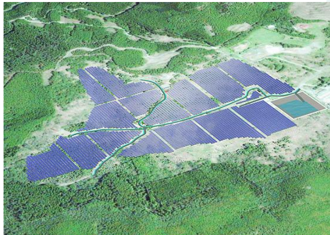
場所: 熊本県葦北郡芦北町高岡 規模: 約21.5MW
