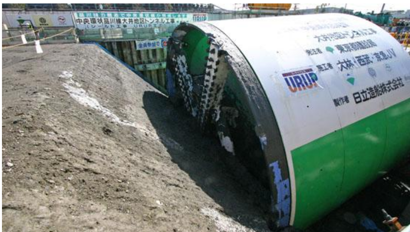
(URUP工法で地上から発進するシールドマシン)
