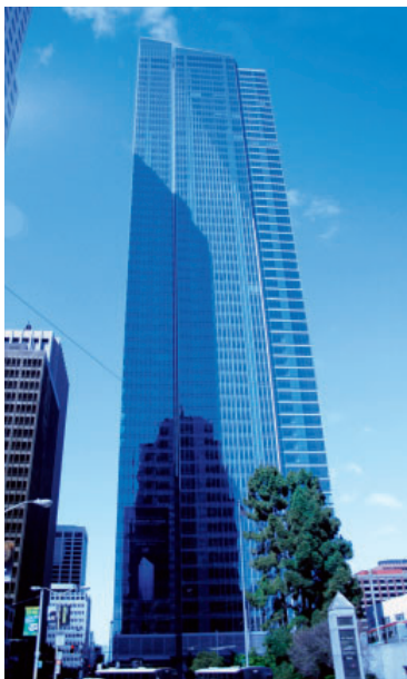
ミレニアム・タワー (301 ミッション・ストリート) 新築工事(米国)
