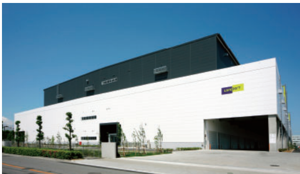
ランドポート川越新築工事(埼玉県)
