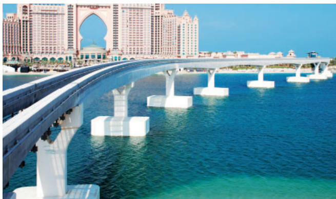
パームジュメイラ モノレール建設工事(アラブ首長国連邦)
