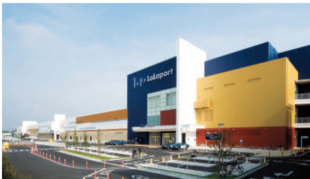
ららぽーと磐田新築工事(静岡県)
