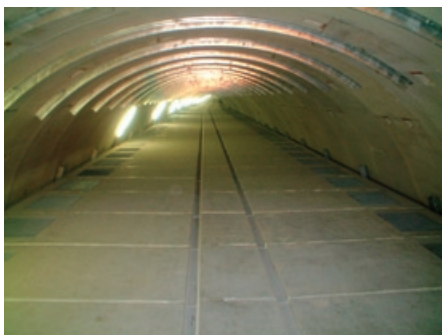
26号大和川共同溝（その2）工事（大阪府）
