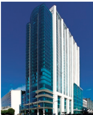
インターコンチネンタルホテル サンフランシスコ新築工事（米国）
