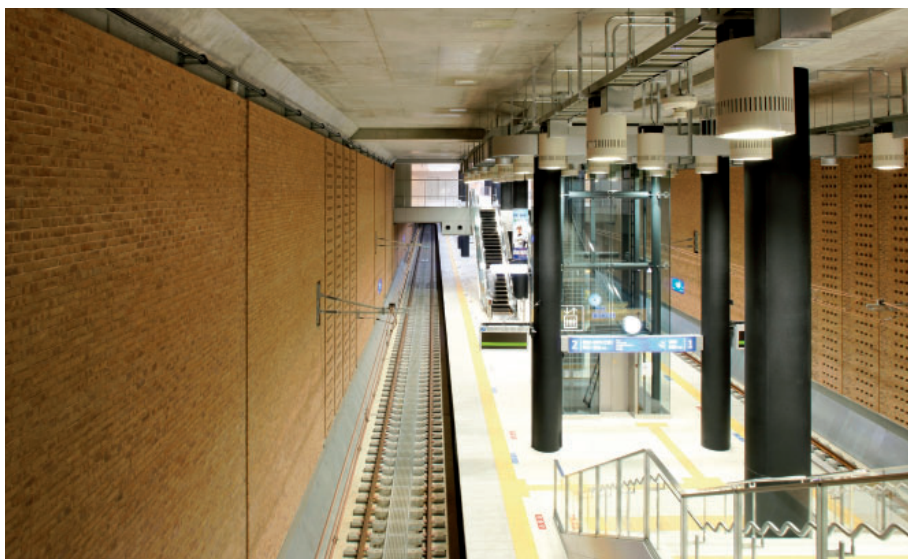
阪神なんば線建設工事(ドーム前駅工区)(大阪府)
