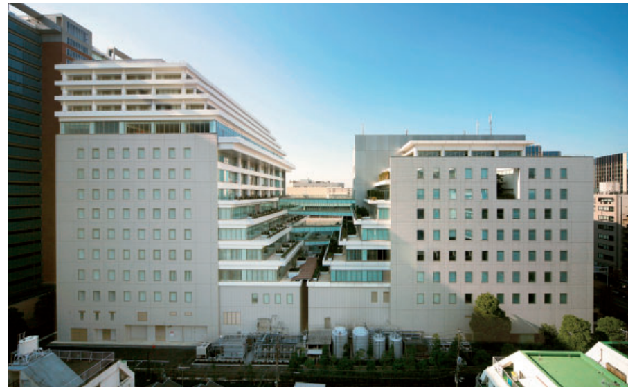
ディスコR&Dセンター増築工事(東京都)
