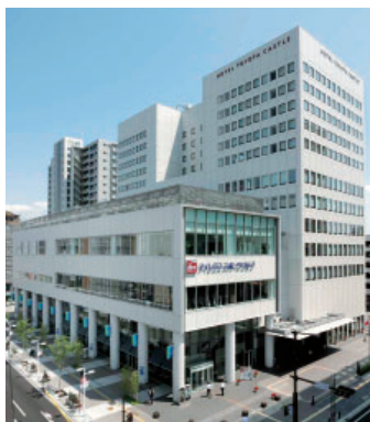
コモ・スクエア新築工事(愛知県)
