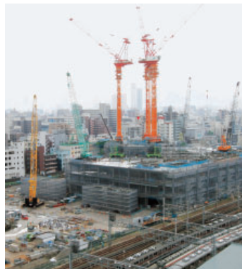
工事現場の状況
