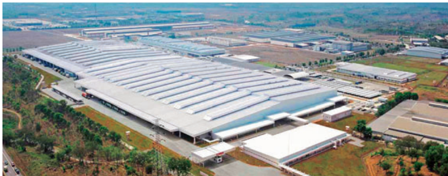
ヤマハ発動機西ジャワ工場第2期建設工事(インドネシア)
