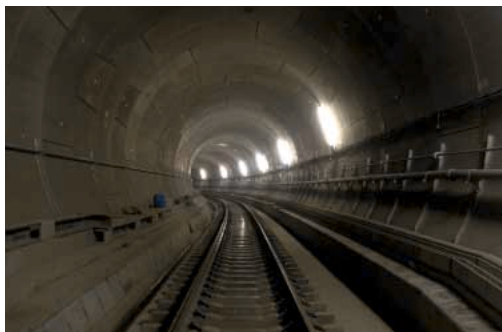
東京地下鉄副都心線 池袋～雑司が谷間トンネル (東京都)
