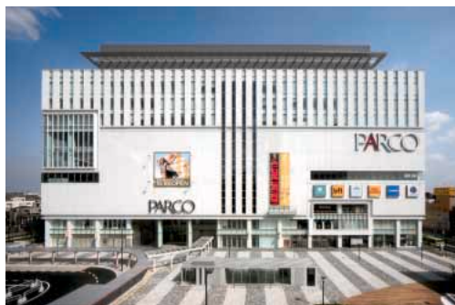
浦和駅東口駅前地区第二種市街地再開発事業 (埼玉県)
