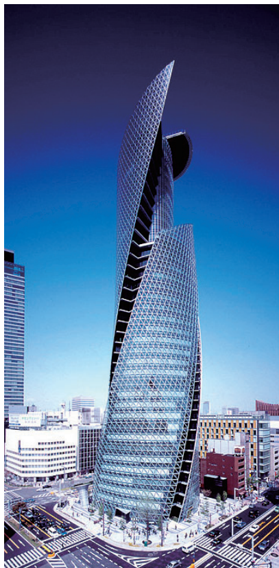
モード学園スパイラルタワーズ新築工事（愛知県）
