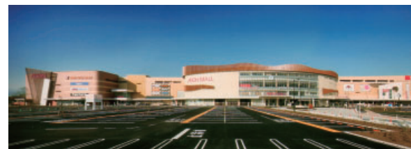
イオンモール日の出新築工事（東京都）
