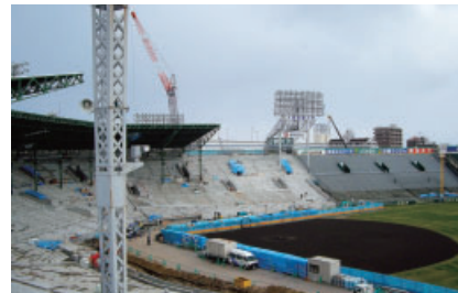
改修中の状況（内野席を撤去）
