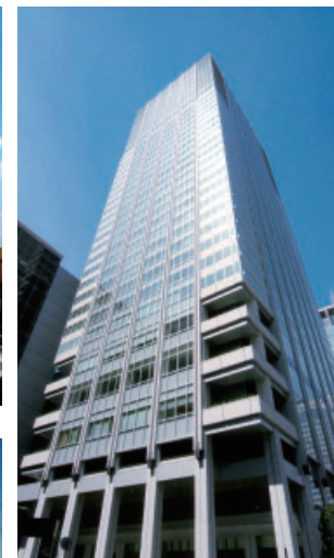
東京駅日本橋口ビル新築工事（東京都）
