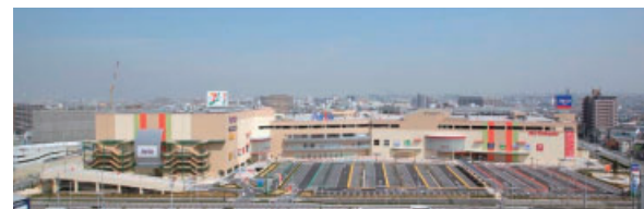
アリオ鳳ショッピングセンター新築工事（大阪府）
