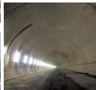
三遠南信鳳来地区三遠トンネル新設工事（愛知県）
