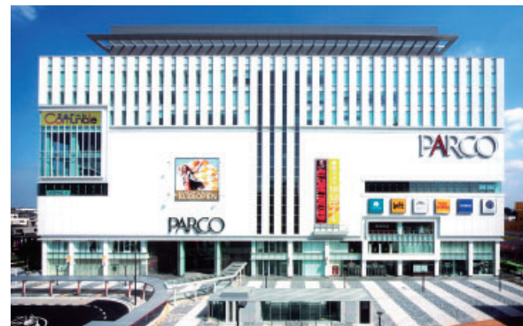
浦和駅東口駅前地区第二種市街地再開発事業特定施設建築物新築工事（埼玉県）
