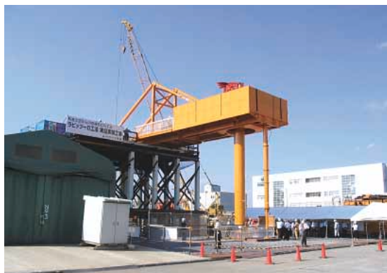
ラビッツ-O工法実証実験の様子
