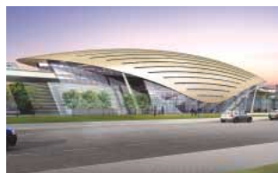
ドバイ都市交通システムの駅舎
