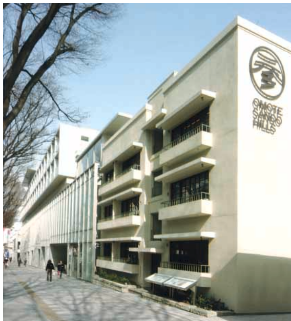
「表参道ヒルズ」の外観。一部に同潤会青山アパートを再現している
