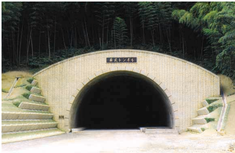
蘇武トンネル（兵庫県）
