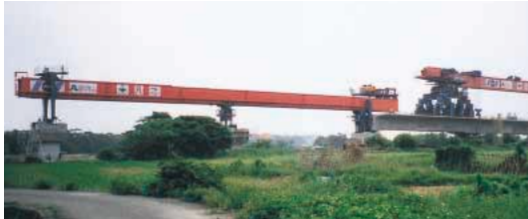
長さ約30m、重さ750tの橋桁の架設状況
