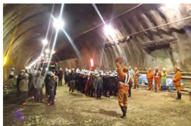
現場を歩きながらトンネルの造り方を紹介
