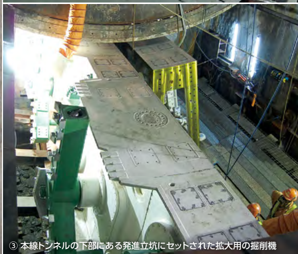
② 本線トンネル(分合流部)
