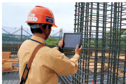
工事黒板カメラの活用
