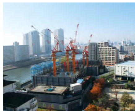
千住関屋ポンプ所
