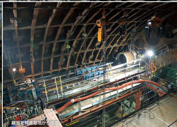
③ 本線トンネルの下部にある発進立坑にセットされた拡大用の掘削機
