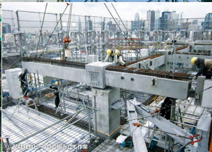
② 部材をクレーンで揚重して組み立て場所に移動
