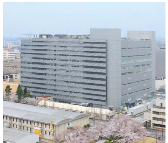
トヨタ自動車(株)パワートレーン共同開発棟
