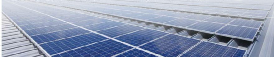
場所：京都府久世郡久御山町 規模：約1.0MW
