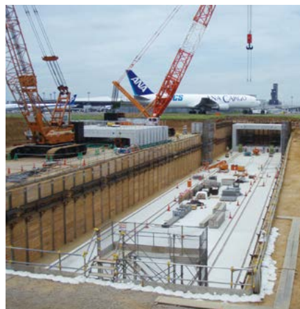
成田国際空港第2木の根トンネル
