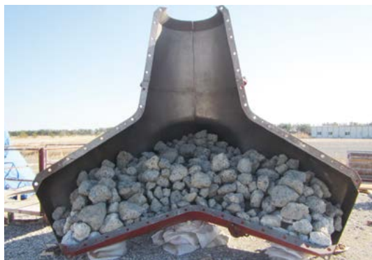
消波ブロック型枠へのコンクリートがら充てん状況
