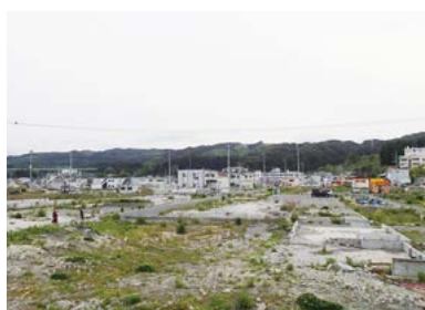
津波による被害を受けた市街地の状況
