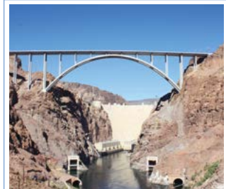
フーバーダムバイパスプロジェクト コロラドリバー橋
