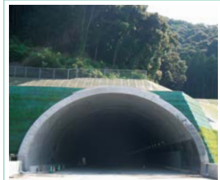
新東名高速道路 島田第一トンネル上り線
