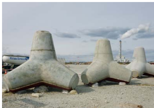
完成した消波ブロック
