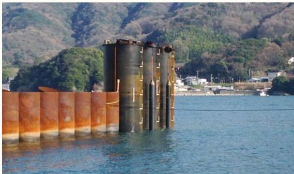
海面上約7.5mの高さまで浮上した防波堤
