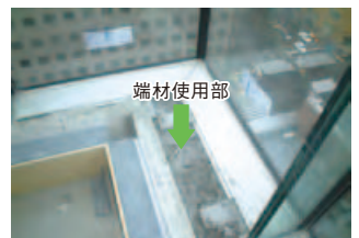
耐火被覆材料(岩綿)の端材を各階の塞ぎ材に有効利用
