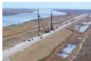
堤防改修工事の現地の状況
