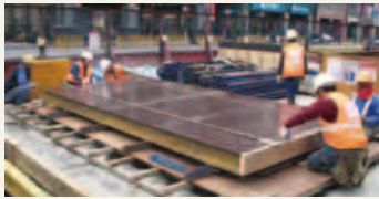
厚さ18mmのPliwood材を採用した木製型枠
