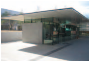
高品質再生骨材を使用した打放しコンクリート壁の建物
