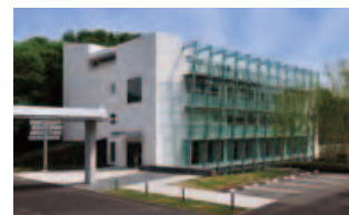
コンバージョン後の外観
