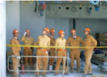
浜松旭板屋再開発JV工事事務所での特別パトロールの様子(2010年5月)
