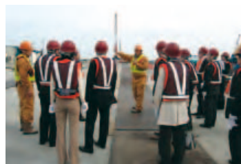
羽田空港D滑走路での建設現場見学会
