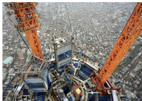
安全設備を取り付けた鉄骨をクレーンで吊り上げて据え付ける様子
