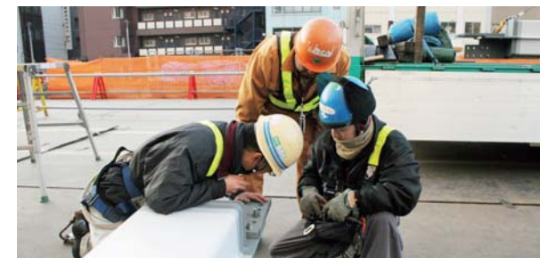
鉄骨が指示通りに加工・納入されているかを、建設現場にて慎重に確認
