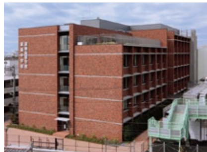
淑徳中学・高等学校主校舎 ('10) 所在地／東京都板橋区
