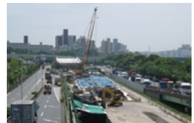
工事の様子。交通量の多い道路に挟まれた箇所での施工となった
