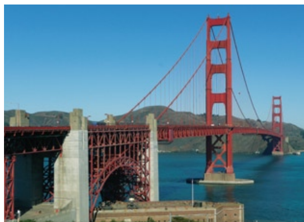
ゴールデンゲートブリッジ耐震補強 ('08) 所在地／米国 カリフォルニア州サンフランシスコ市
