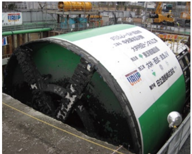
シールドマシンの地上発進状況
