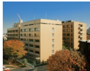
東京大学フードサイエンス棟 ('10) 所在地／東京都文京区
