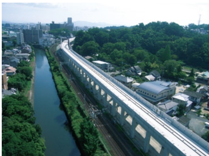
九州新幹線 北岡工区高架橋 ('09) 所在地／熊本県熊本市
