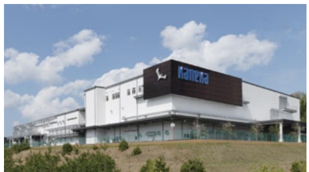
カネカソーラーテック 第二工場棟 ('09) 所在地／兵庫県豊岡市
