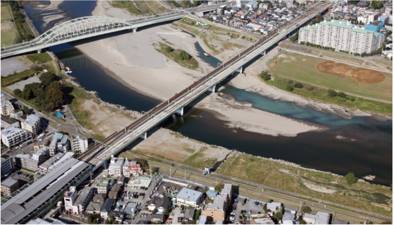
小田急電鉄 多摩川橋梁 （'10） 所在地／東京都狛江市-川崎市多摩区
