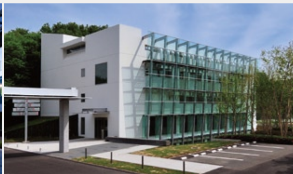
材料化学実験棟
