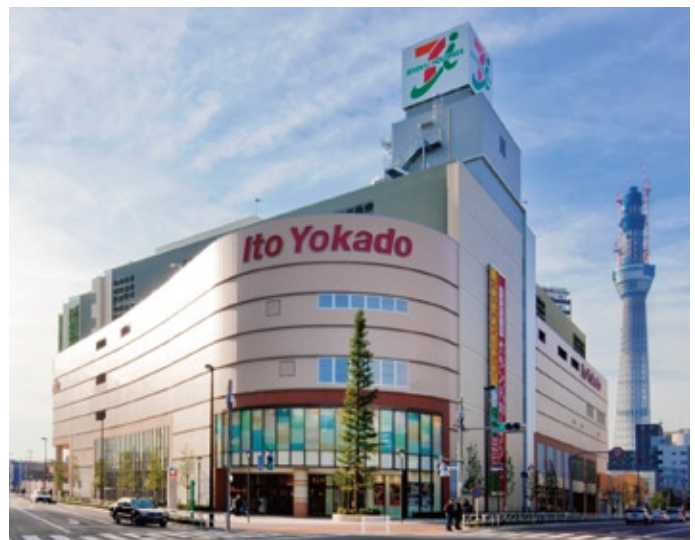
イーストコア曳舟商業館(イトーヨーカドー曳舟店)(‘10) 所在地／東京都墨田区
