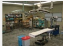
手術室(改修前)
