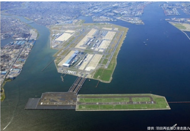
東京国際空港D滑走路 ('10) 所在地／東京都大田区
