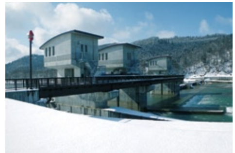
皆瀬頭首工 ※（'09） 所在地／秋田県横手市 ※ 頭首工（とうしゅこう）：農業用水を河川から取水するための施設
