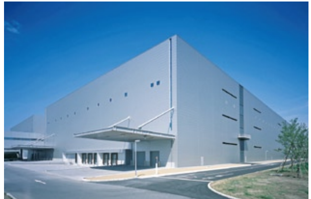
大分キヤノンマテリアル 大分事業所 D棟 ('09) 所在地／大分県大分市
