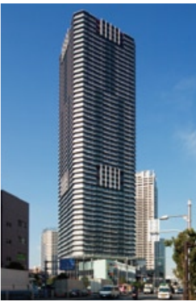
勝どき駅ビュートワー （'10） 所在地／東京都中央区
