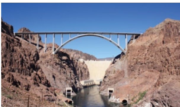
フーバーダムバイパスプロジェクト コロラドリバー橋 ('10) 所在地／米国 ネバダ州-アリゾナ州
