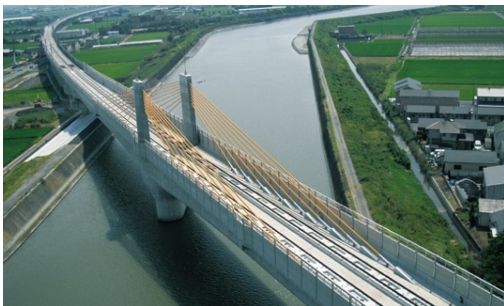
九州新幹線 大野川橋りょう ('09) 所在地／熊本県宇城市
