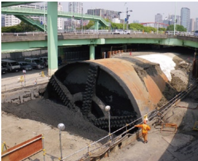
到達時。外径13.6m、重さ1,500tの泥土圧式シールドマシンが姿を現した
