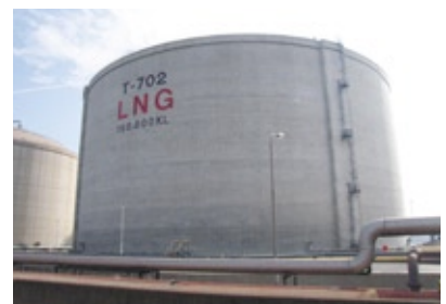
水島LNG 液化天然ガスタンク ('10) 所在地／岡山県倉敷市
