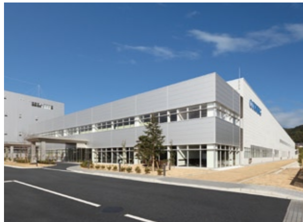
コーニングジャパン 静岡工場新棟（'10） 所在地／静岡県掛川市
