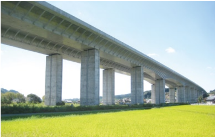
第二東名高速道路 宮ヶ島高架橋 （'10） 所在地／静岡県掛川市
