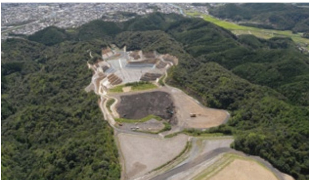
鶴の内第二次鉱滓処分場 （'10） 所在地／宮崎県日向市
