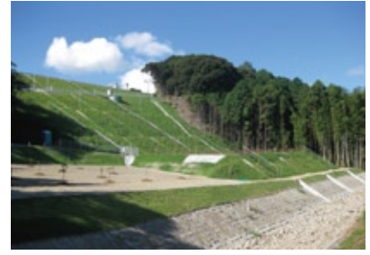
東名高速道路 牧之原地区災害本復旧 ('10) 所在地／静岡県島田市-牧之原市
