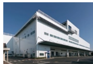
本田技研工業 S-1工場（'10） 所在地／浜松市中区
