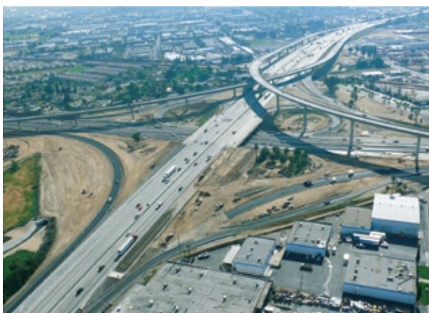
カリフォルニア高速道路215号線拡幅・立体交差 ('08) 所在地／米国 カリフォルニア州リバーサイド郡
