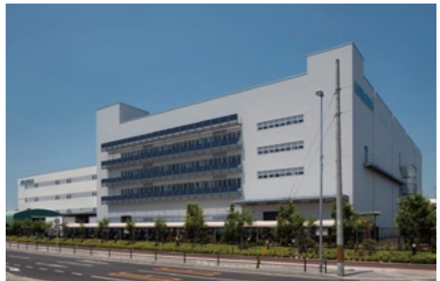
三菱電機 冷熱システム製作所7工場 ('10) 所在地／和歌山県和歌山市
