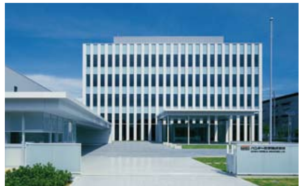
バンドー化学本社事業所('07) 所在地／神戸市中央区
