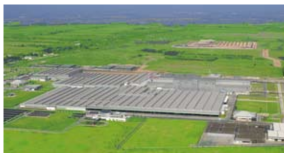
トヨタモータータイランド バンボー工場 ('06)
