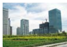
屋上緑化システム
