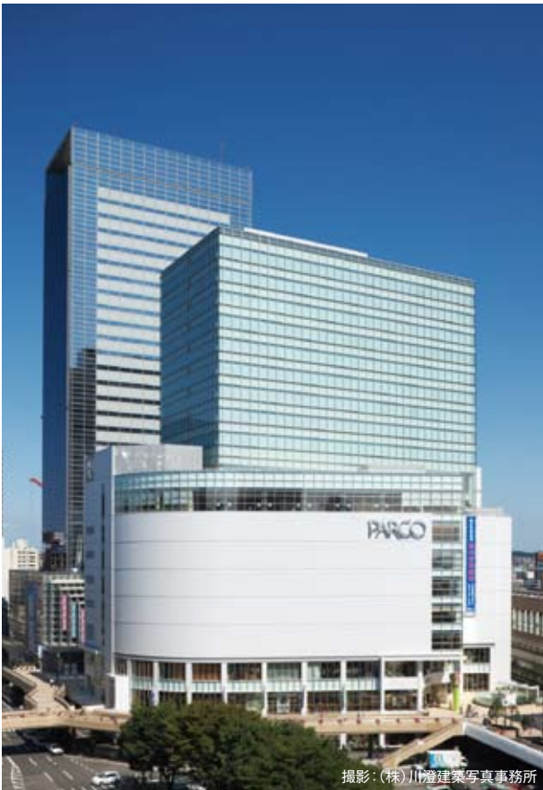
仙台マークワン('08) 所在地／仙台市青葉区
