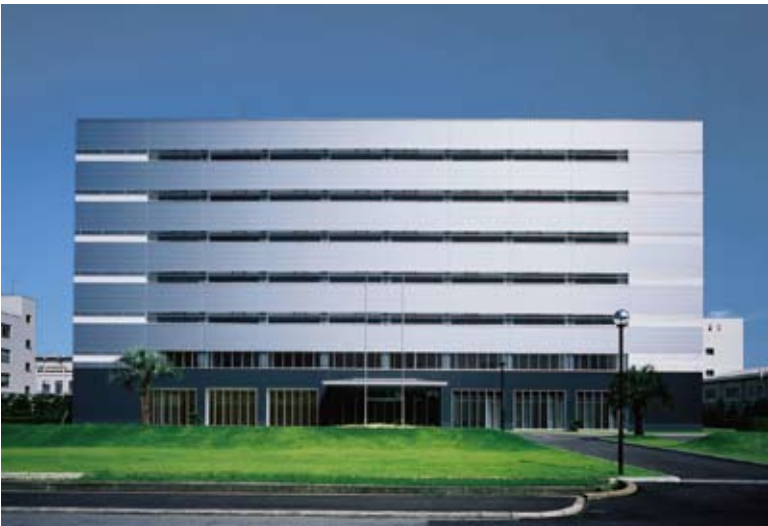
三菱電機 西部地区研究所IS棟 （'08） 所在地／兵庫県尼崎市
