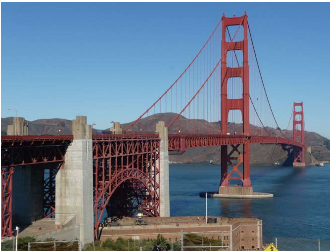
ゴールデンゲートブリッジ耐震補強('08) 所在地／米国 カリフォルニア州サンフランシスコ
