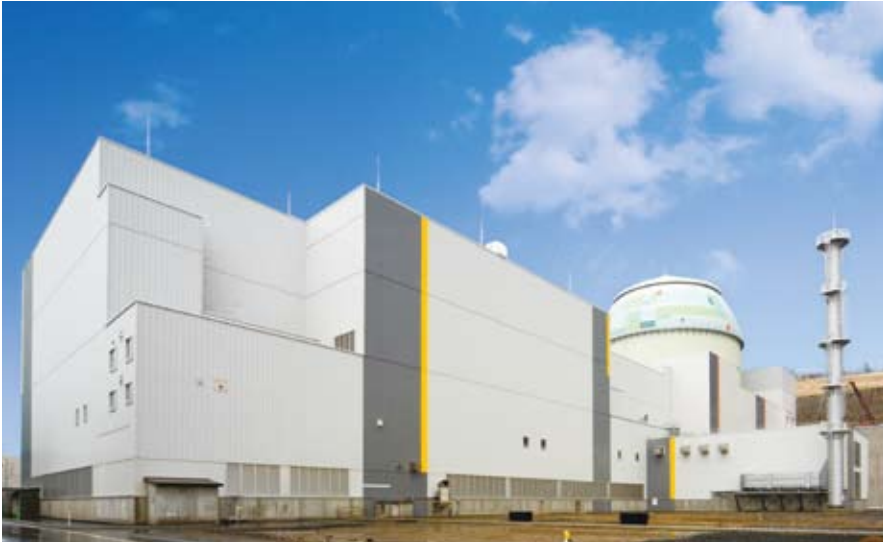
北海道電力 泊発電所3号機タービン建屋他 ('08) 所在地/北海道古宇郡
