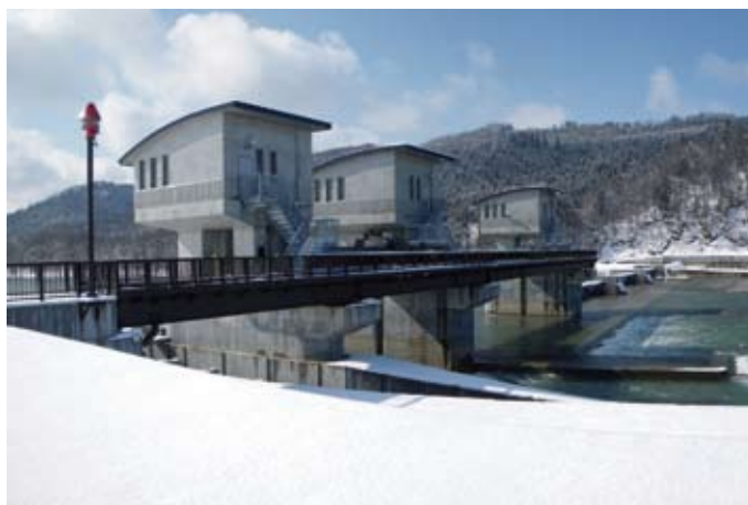
皆瀬頭首工*('09) 所在地／秋田県横手市 ※頭首工(とうしゅこう)：農業用水を河川から取水するための施設
