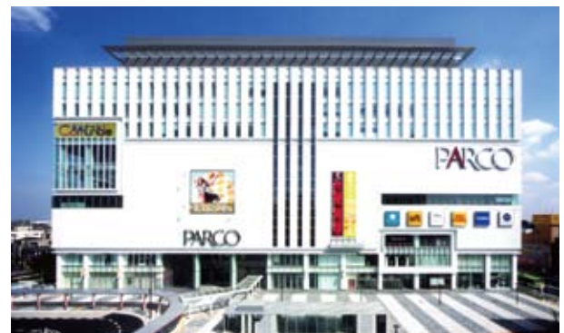
浦和駅東口駅前地区 第二種市街地再開発事業特定施設建築物('07) 所在地／さいたま市浦和区
