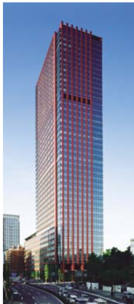
住友不動産三田ツインビル西館（'06） 所在地／東京都港区
