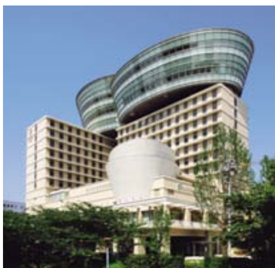
シティプラザ大阪 ('06) 所在地／大阪市中央区
