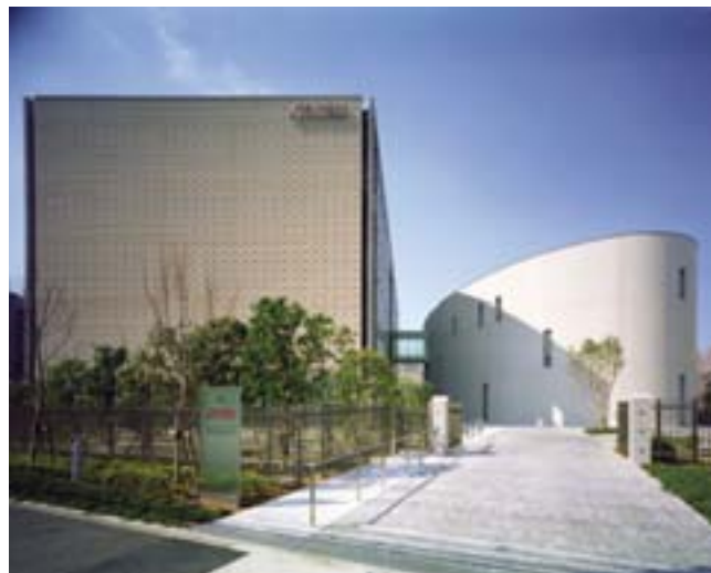
資生堂美容技術専門学校 ('06) 所在地／東京都板橋区
