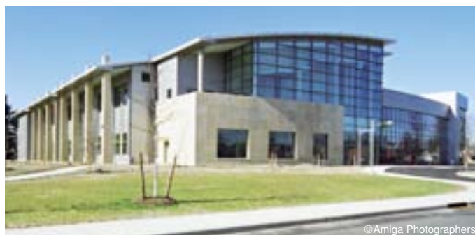
ブルックヘブン国立研究所 ナノマテリアルセンター ('07) 所在地/アメリカ ニューヨーク州 アプトン市 施工/EWハウエル (大林組グループ)
