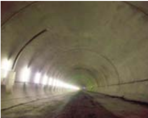
三遠南信鳳来地区三遠トンネル ('08) 所在地/愛知県新城市
