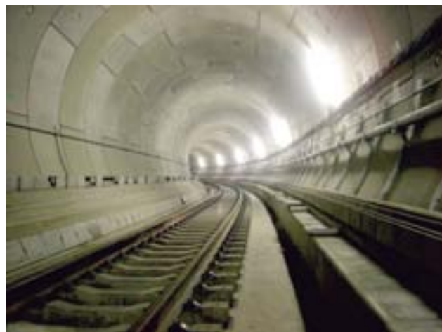
東京メトロ副都心線 南池袋A線工区 ('07) 所在地／東京都豊島区
