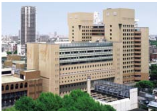
東京大学医学部附属病院中央診療棟（'06） 所在地／東京都文京区
