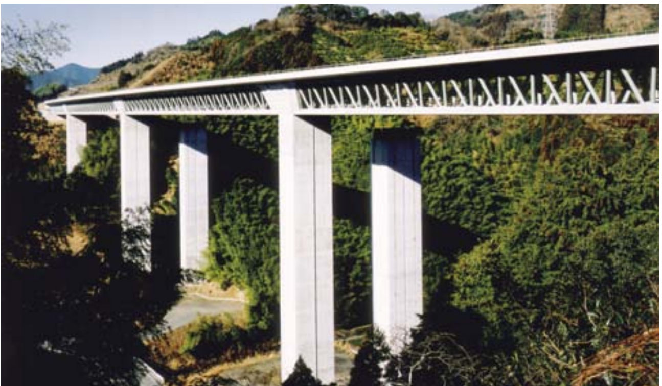
第二東名高速道路 猿田川橋・巴川橋 (’06) 所在地／静岡県静岡市
