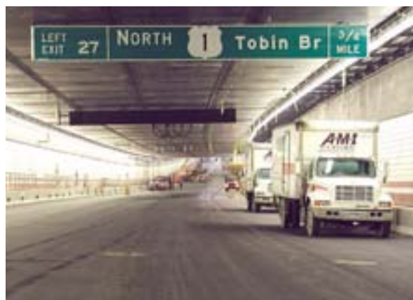
ボストン中央幹線道路 93号線トンネル ('06) 所在地/アメリカ マサチューセッツ州 ボストン市
