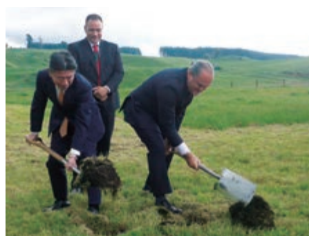
水素プラント建設予定地で行われた鉄入れ式
