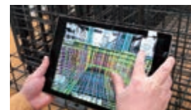
次世代型自動品質検査システム (BIMモデルと現実の配筋の重なりを確認)
