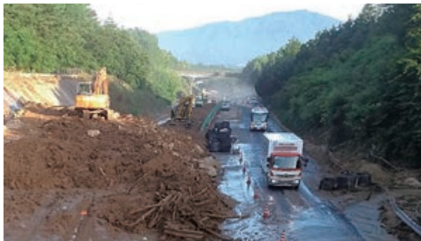
流入物を移動して1車線を確保（山陽自動車道復旧工事）
