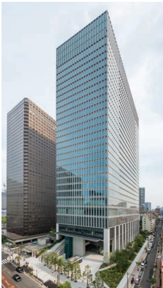
日本生命浜松町クレアタワー新築工事（東京都）
