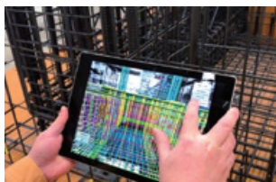
BIMモデルと現実の配筋の重なりを確認
