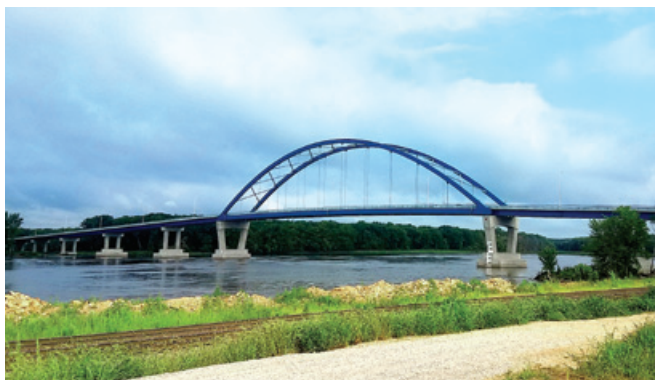
ミシシッピ川サバンナ橋架替工事(米国)
