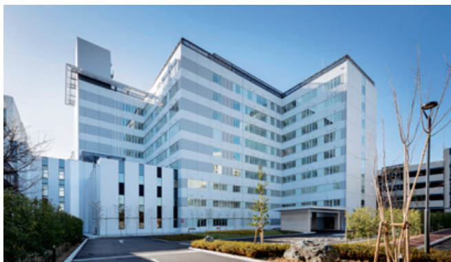
藤田医科大学病院B棟新築工事(愛知県)
