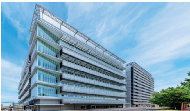
トヨタ自動車(株) 本社工場パワートレーン3号館工事(愛知県)
