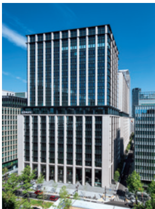
(株)三菱UFJ銀行大阪ビル 建替工事(大阪府)
