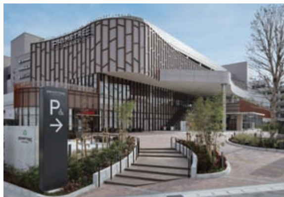
プライムツリー赤池新築工事（愛知県）
