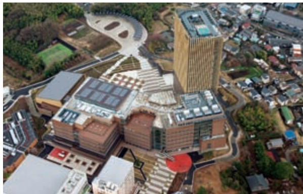
帝京大学八王子キャンパス ソラティオスクエア新築工事（東京都）
