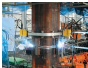
角形鋼管柱のロボット溶接
