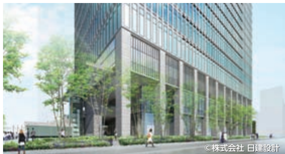
緑樹を配した低層部の外観（イメージ）
