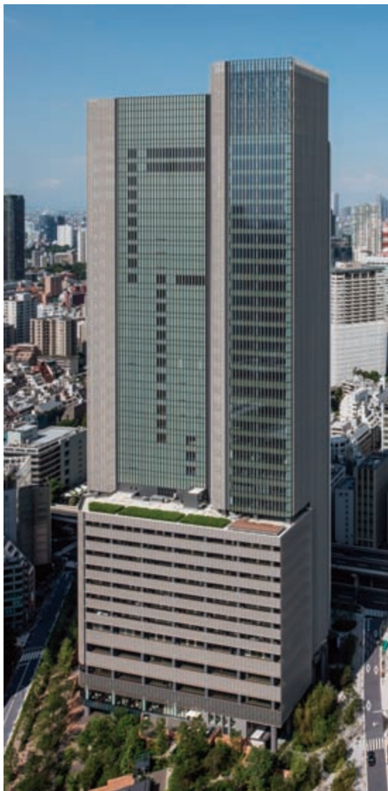
赤坂インターシティA1R新築工事（東京都）
