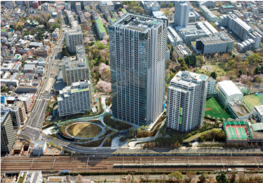
新宿ガーデンタワー新築工事(東京都)
