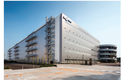
三井不動産ロジスティクスパーク日野新築工事(東京都)
