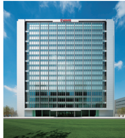
キヤノン川崎事業所高層棟新築工事(神奈川県)
