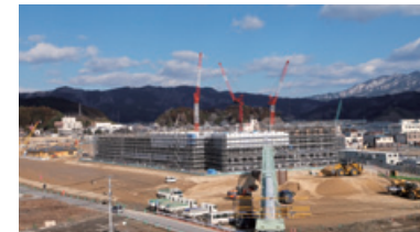
山田地区では、合計140戸の災害公営住宅の建設を当社の設計・施工で進めています。
