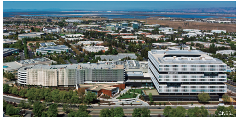
サムスン半導体新社屋新築工事(米国)
