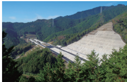
新東名高速道路 稲木トンネル他1トンネル工事(愛知県)
