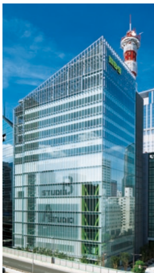
毎日放送本社新館建設工事(大阪府)
