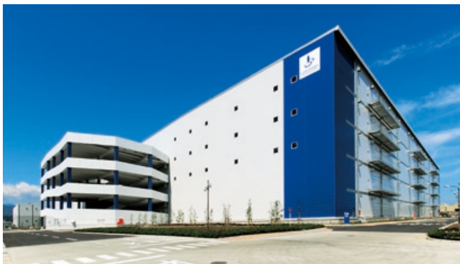
ロジポート相模原新築工事(神奈川県)
