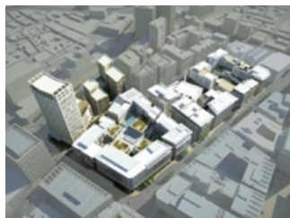
4期にわたり段階的に発注されるムシェレブ・ダウンタウン・ドーハ・プロジェクトのうち、第3期工事を手掛けます。
