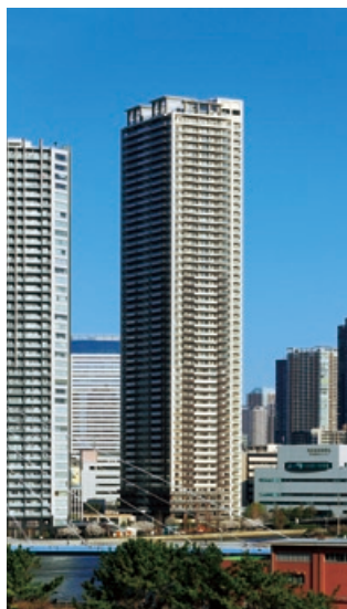
プラウドタワー東雲キャナルコート 建設工事(東京都)
