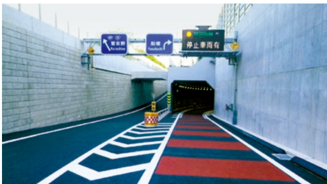
東関東自動車道 谷津船橋インターチェンジ工事(千葉県)
