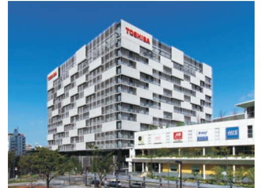
ラゾーナ川崎東芝ビル新築工事(神奈川県)
