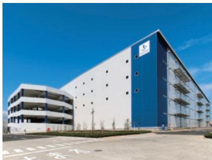
ロジポート相模原新築工事(神奈川県)
