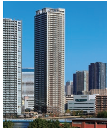
プラウドタワー東雲チャンネルコート建設工事 (東京都)
