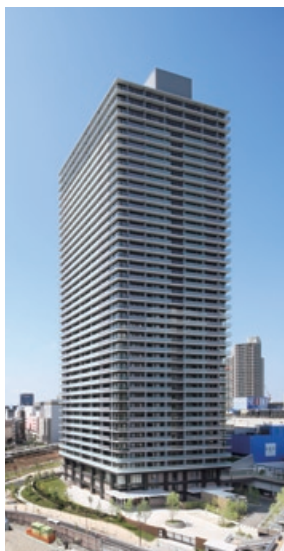
ジオタワー高槻ミューズフロント 建設工事(大阪府)
