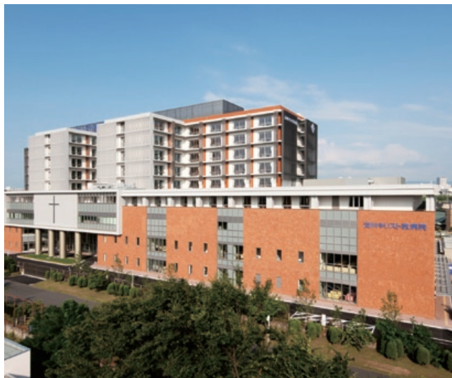
淀川キリスト教病院建設工事(大阪府)
