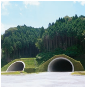
第二東名高速道路 秦梨トンネル建設工事 (愛知県)
