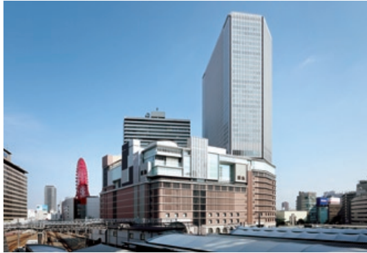
梅田阪急ビル建替工事のうち新築工事(大阪府)
