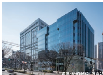
提供：森新建築社 写真部 4月4日に開業した「oak omotesando(オーク表参道)」が、当社が最新技術を駆使して施工し、大林不動産が運用、管理する商業施設とオフィスの複合ビル
