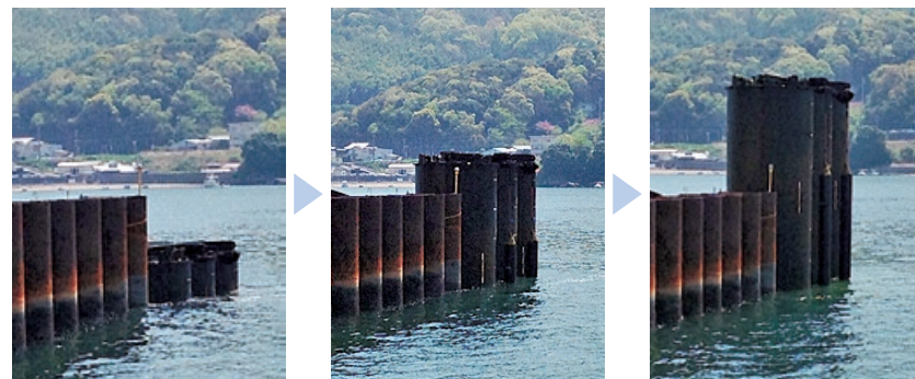
動作確認試験の様子。(左から)海底に格納した3本連結の鋼管(幅9m)が高圧空気の送気により徐々に浮上し、高さ7.5mに到達しました。
