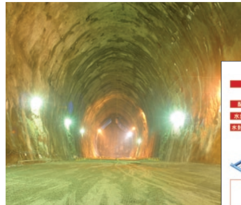
波方基地ボタン貯槽工事(愛媛県)
