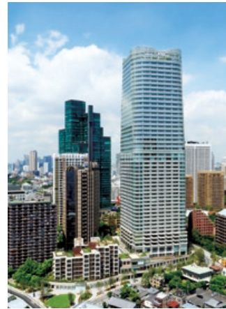
虎ノ門・六本木地区第一種市街地再開発事業に伴う施設建築物新築建築工事(東京都)
