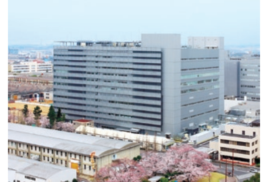
トヨタ自動車㈱PT棟新築工事(愛知県)
