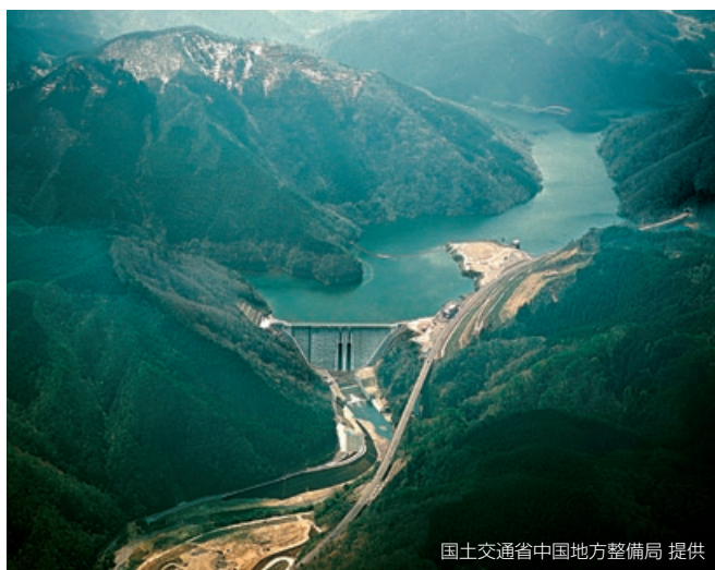
志津見ダム建設工事(島根県)
