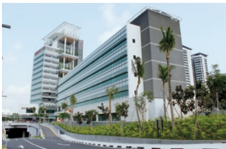
シンガポール国立大学内 研究施設棟建設工事 (シンガポール)
