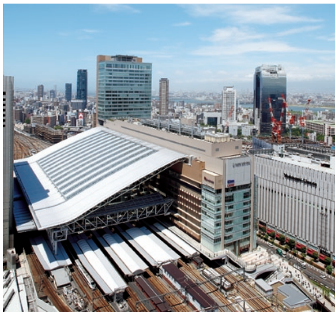
大阪駅新北ビル(ノースゲートビルディング)新築工事(大阪府)
