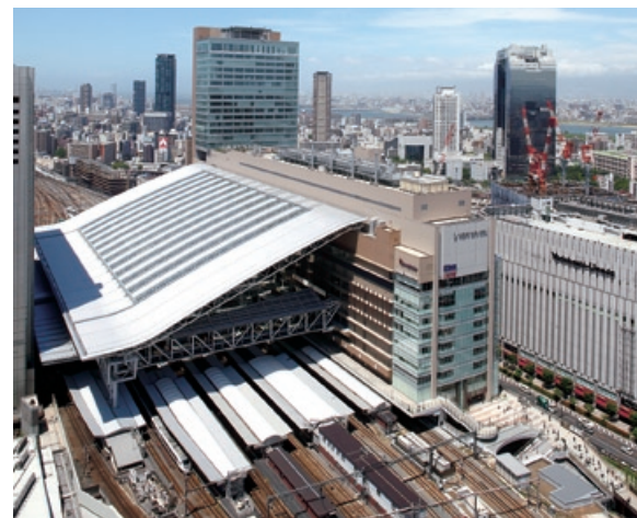
大阪駅新北ビル(ノースゲートビルディング)新築工事(大阪府)
