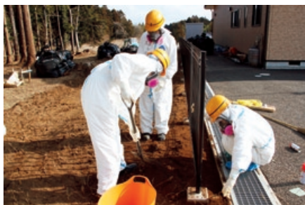
防護服を着用した作業員による除染作業
