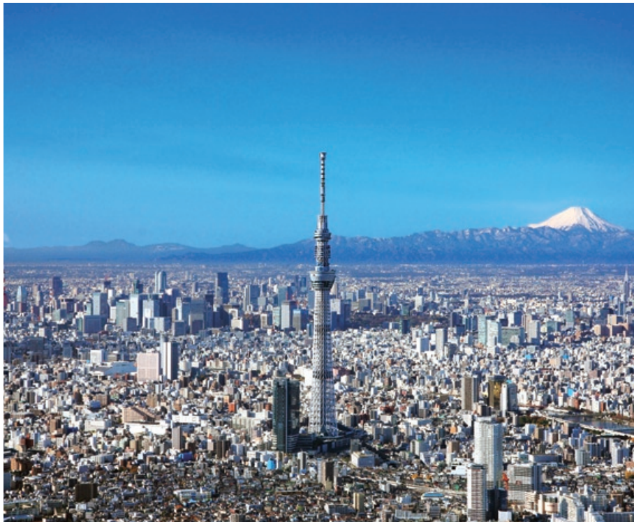
東京スカイツリー® 建設工事(東京都)
