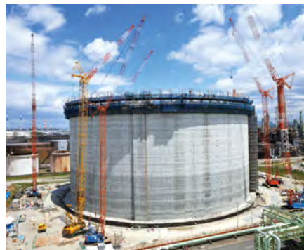
No. 5 LNG tank at the Senboku terminal of Osaka Gas Co., Ltd.
